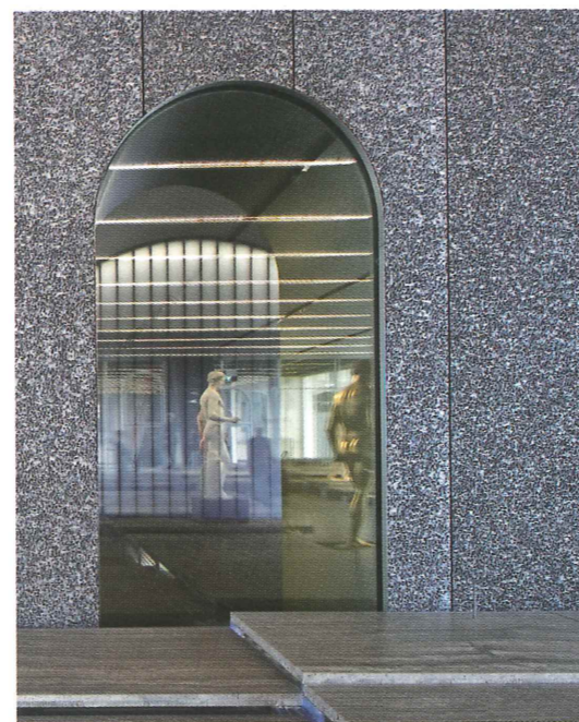
L'ingresso coperto al Podium e all'edificio di 4 piani chiamato Haunted House avviene dalla corte centrale. Accanto, dettaglio dei rivestimenti schermanti e fonoassorbenti in schiuma di alluminio Alusion impiegati nel Podium. Sotto, assonometria del sito: in colore gli edifici di nuova costruzione, tra cui la Torre alta che è in corso di completamento (foto ©Moreno Maggi, disegno ©OMA).
