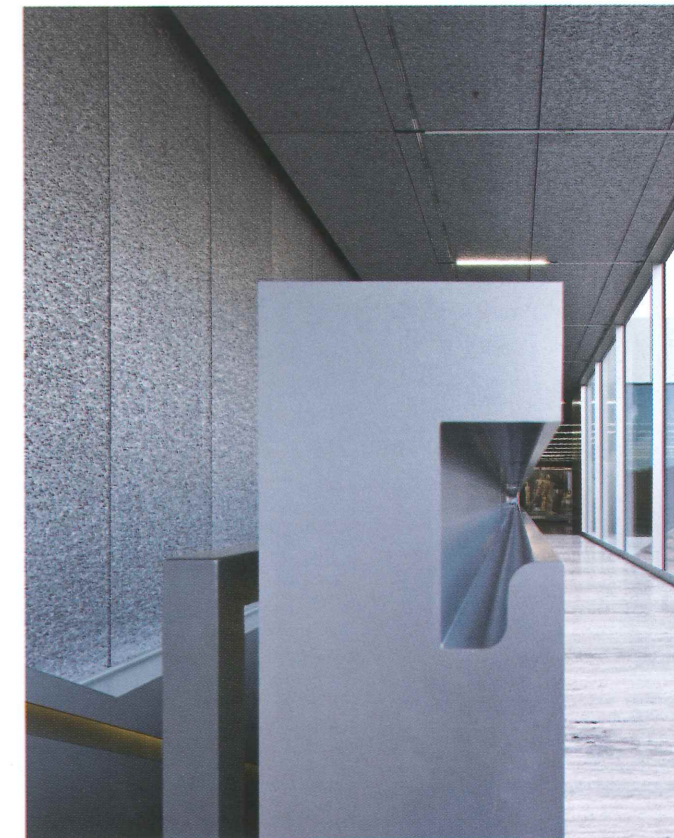
Dettagli: balastra corrimano al primo piano del Podium ; foglia d'oro, pannelli di schiuma di alluminio Alusion™, rivestimenti in policarbonato (foto ©Moreno Maggi).
